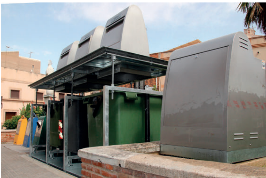
▲ Nuevas plataformas hidráulicas en el Cristo del Amor.
