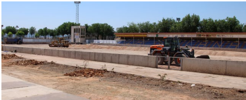
▲ Obras de reforma en La Moheda
