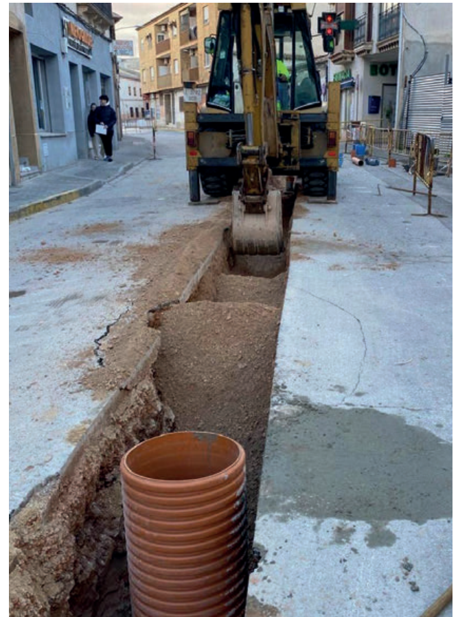
▲ Nuevo colector de la calle Encomienda.
