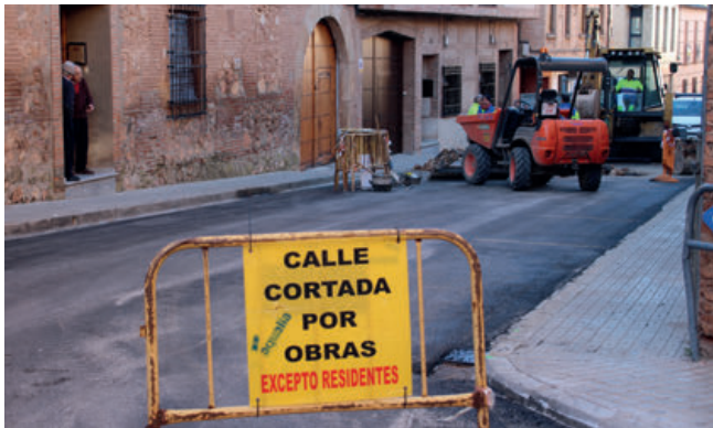
▲ Calle Comendador, recién asfaltada.
