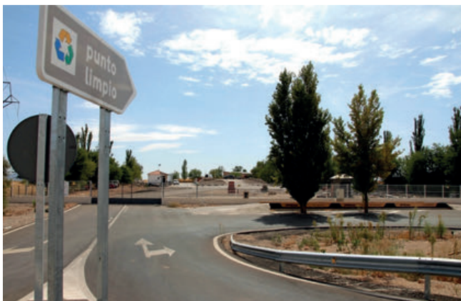
▲ Nuevo acceso al Punto Limpio
