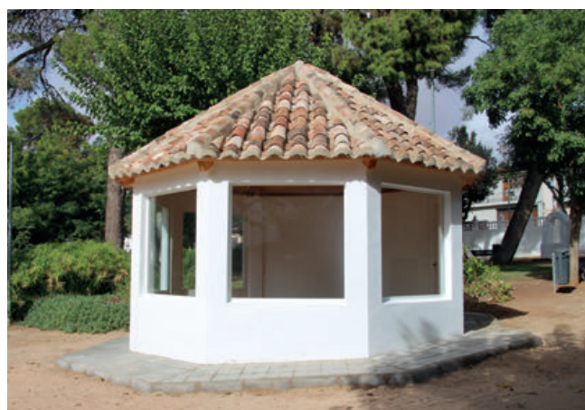
▲ Aspecto de la caseta, recién restaurada
