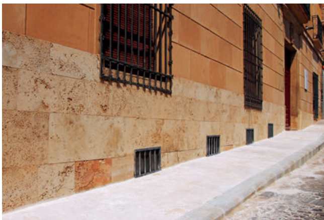
▲ Tramo de acera arreglado
