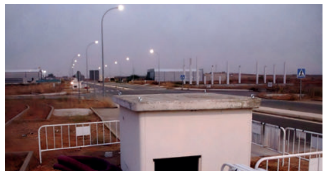
▲ Nuevas casetas de luz en el parque empresarial
