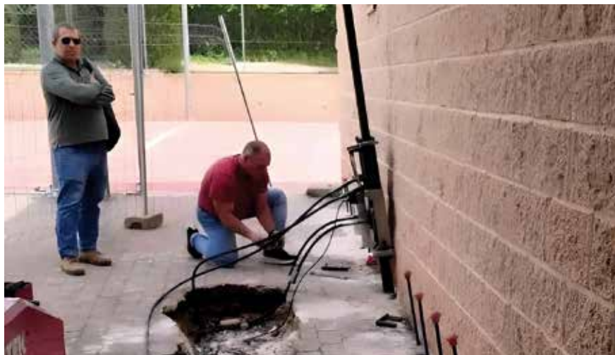
▲ Recalce del pabellón con micropilotes.
