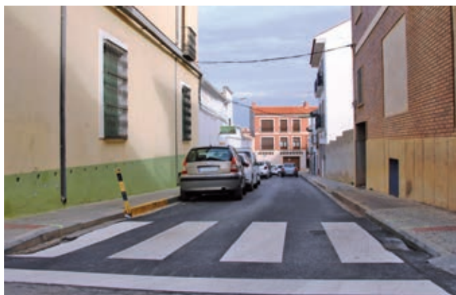
▲ Calle Francisco Javier Bustillo, recién asfaltada.
