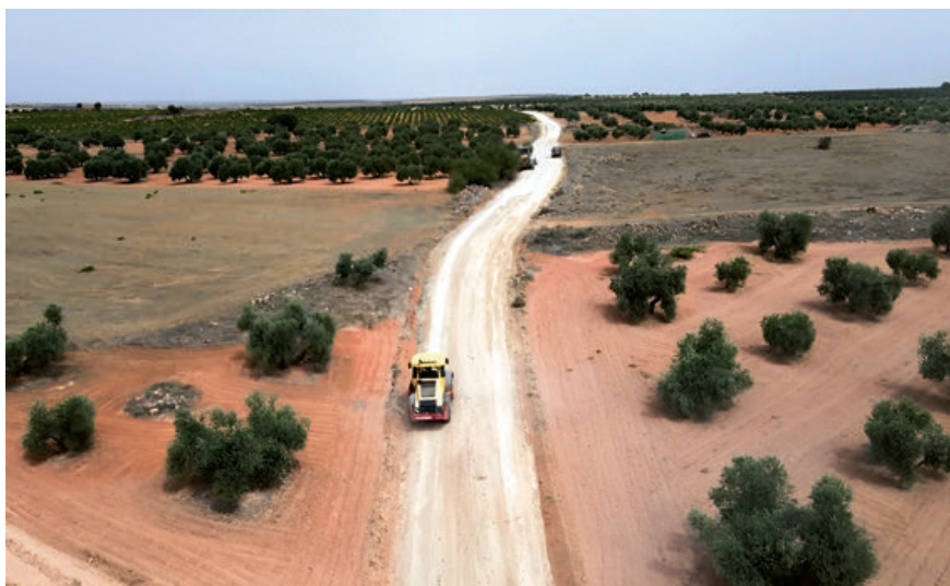
▲ Camino en reparación cerca de La Solana.
