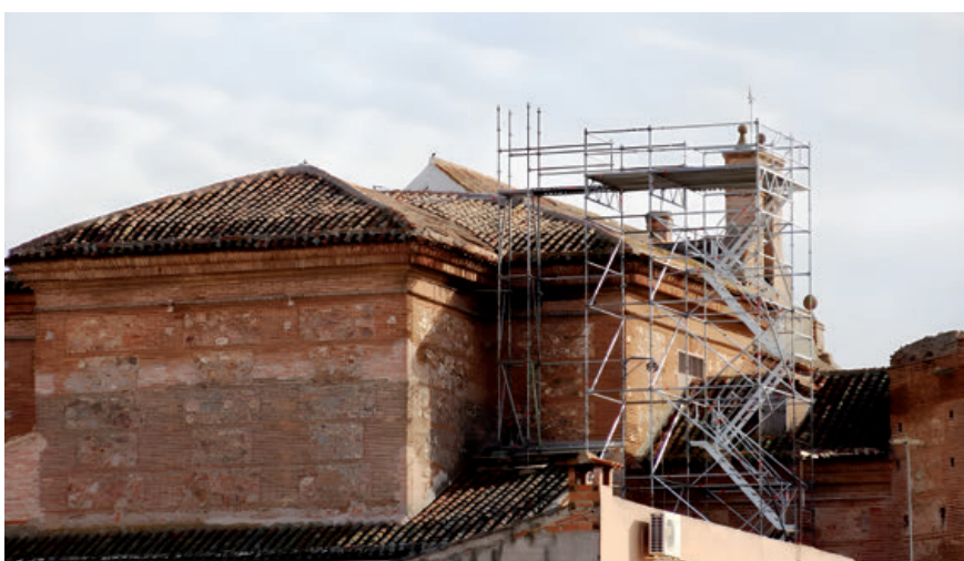
▲ Andamios en la parroquia trinitaria.
