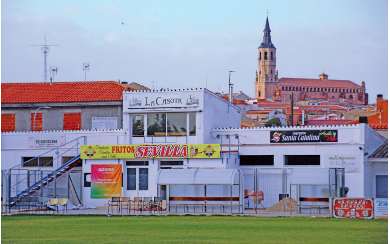
▲ Los vestuarios de La Moheda están en obras.
